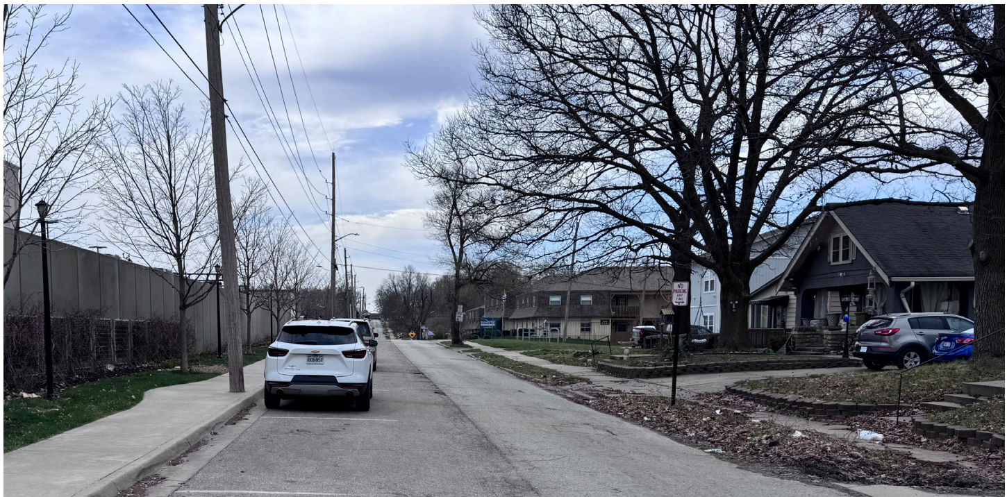
Figura 63. Condición existente en Adams Street Mirando hacia el Sur desde la Avenida 39
