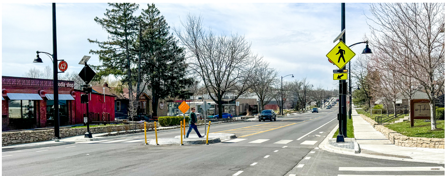
Figura 67. Isla de Refugio Peatonal con Balizas Rápidas Rectangulares Intermitentes en la Avenida 47
